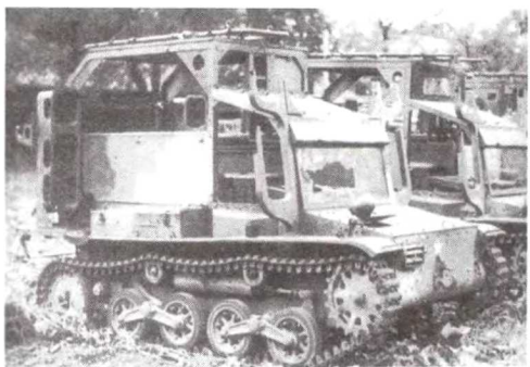
Трофейные транспортеры-укладчики кабеля на шасси малого танка Тип 94 ТК. Видны рамы для укладки кабеля и шестов
