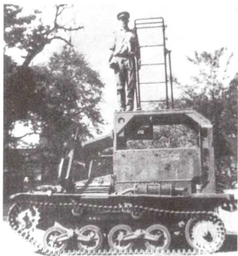
Транспортер-укладчик кабеля в рабочем положении для организации шестовых кабельных линий
