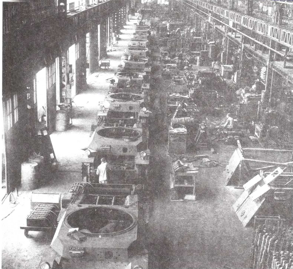
Сборочный цех средних танков Тип 1 «Чи-хе»
